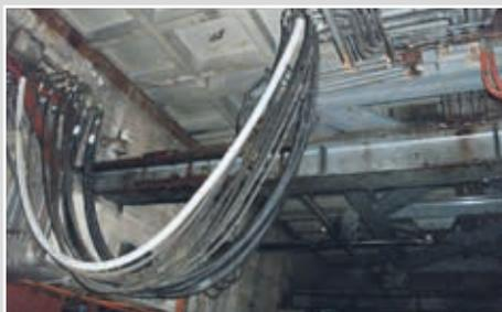
Heizschlauch (DN 50) zur Verbindung von Vorratsbehälter und Löschwasser-Verteilungssystem. Funktion: Frostschutz (+5°C) im Außenbereich. Mediumschlauch aus Polyethylen
