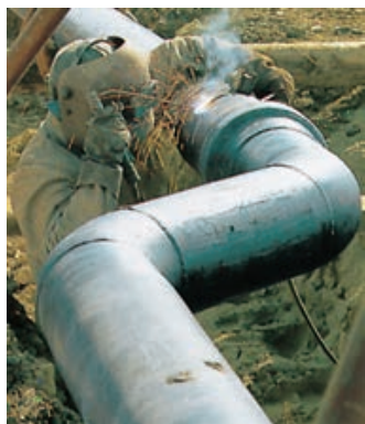
Schweißnaht-Bearbeitung an einer Pipeline mit der gezapften Ultra Einzel-scheiben-Bürste.
